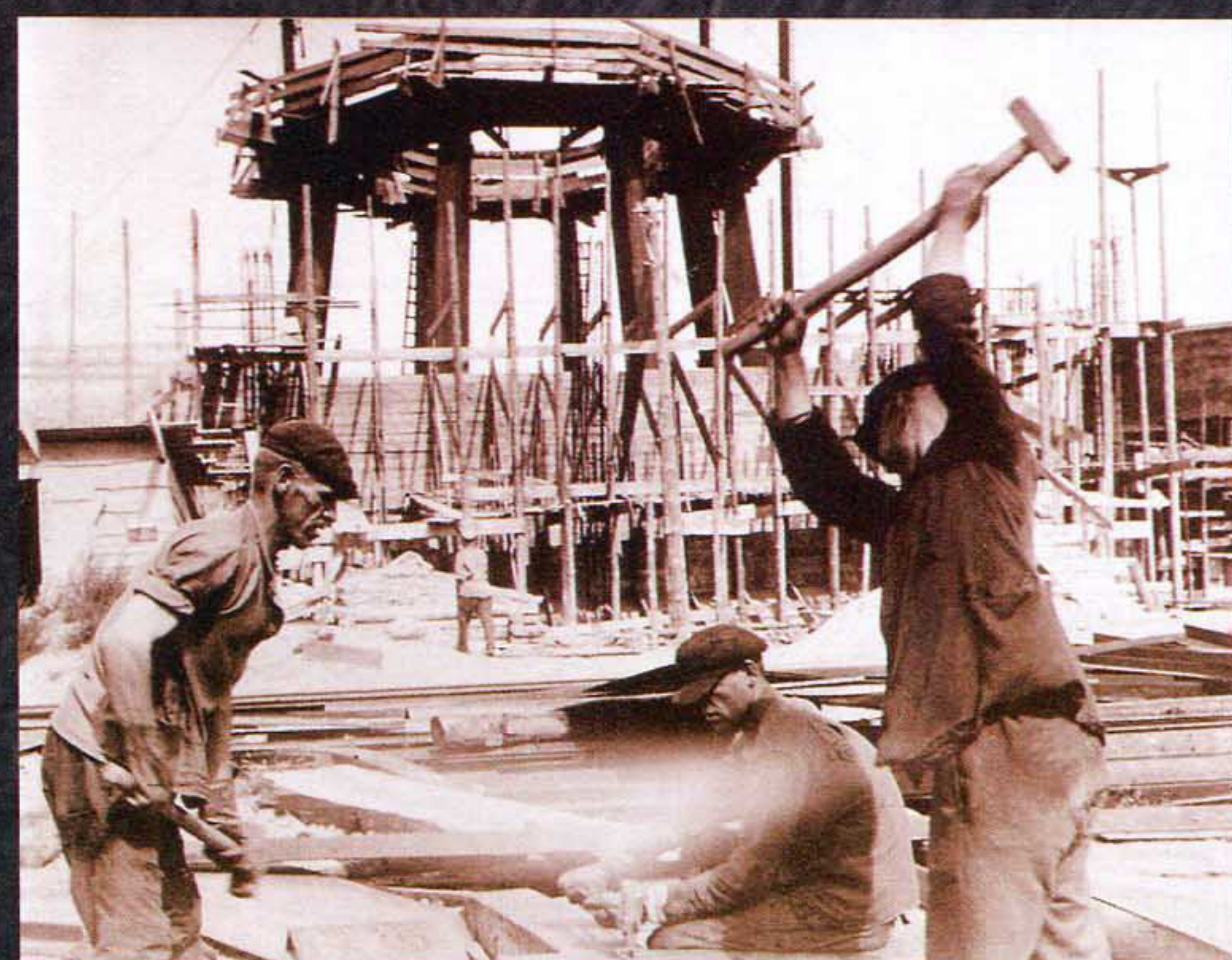
▲ Начало строительства НЛМЗ. 1931 г.
